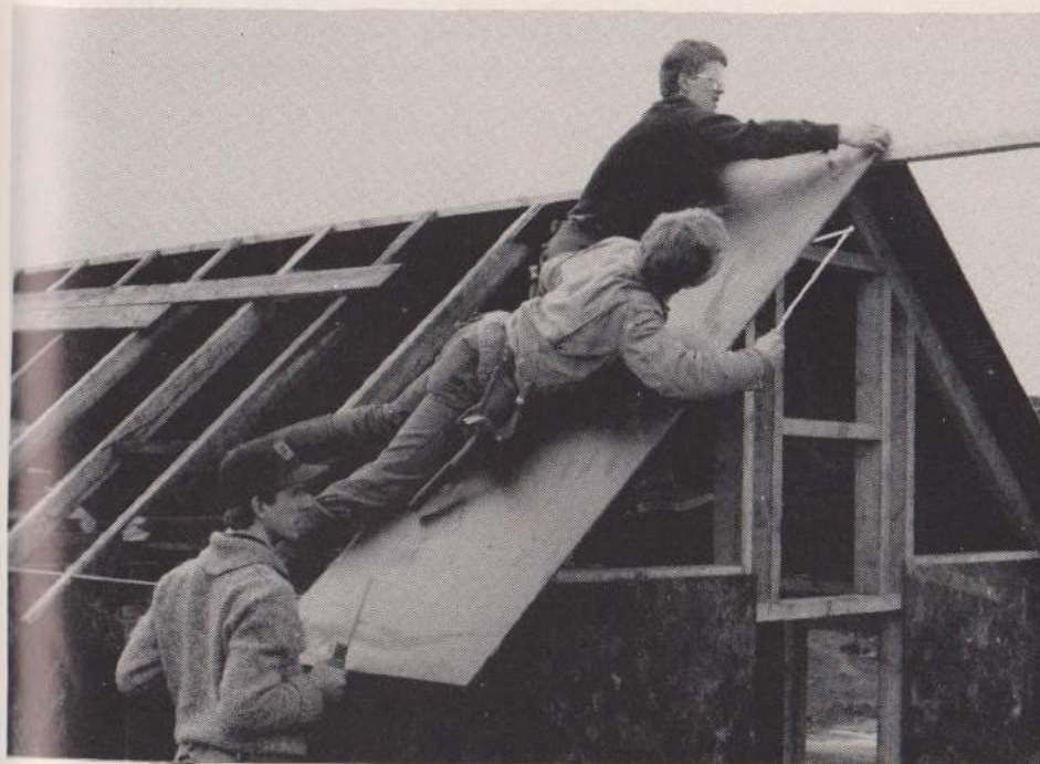
Þakið klætt. Myndina prýða smiðirnir þrír sem borið hafa hita og þunga verksins, neðst Guttormur Þórarinnsson 1. yfirsmiður, þá Jón Rafnsson 2. yfirsmiður og efst Jón Geirsson 3. yfirsmiður. Ljós. Jón Ólafsson, mars '82.
